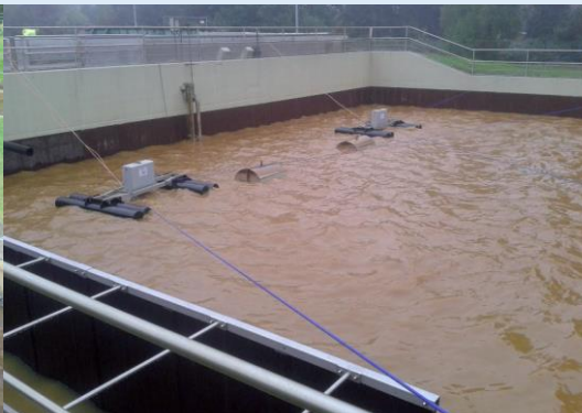
Homogenisierung von Eisenschlamm Homogenisation of iron sludge
