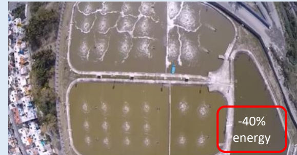
Teichkläranlage mit 12 OLOIDEN + 32 Belüfter Pond Treatment plant with 12 OLOIDS + 32 Aerators
